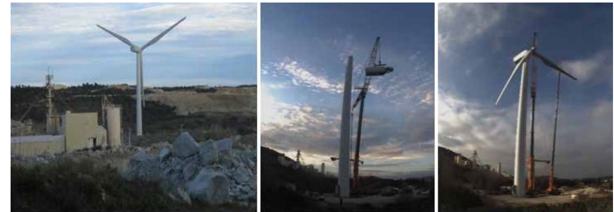
Eolienne de Centernach – Démantèlement de l'éolienne
