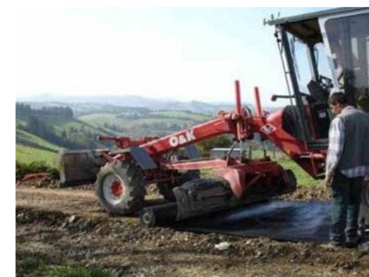
Pose du géotextile
