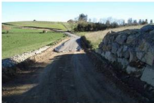
Mise en place du gravier
