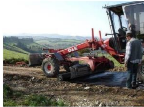
Pose du géotextile
