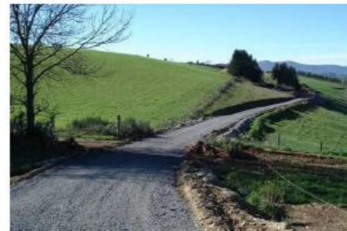
Mise en place du gravier
