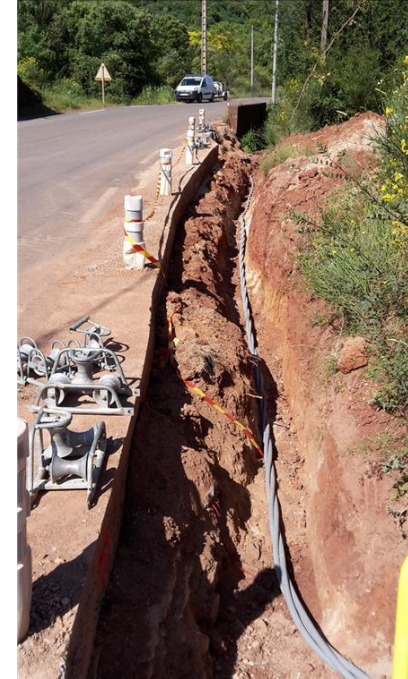
Chantier mobile d'enfouissement de ligne (source : https://actu.fr/normandie/flers_61169/entre-flers-et-tincherbay-cest-la-fin-dun-gros-chantier-denfouissement-de-lignes-electriques_1355402.html )
