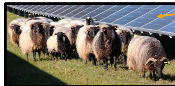
Panneaux fixes inclinés Pâturage ovin en plein air intégral (espacement 4 m, hauteur mini 1 m)
