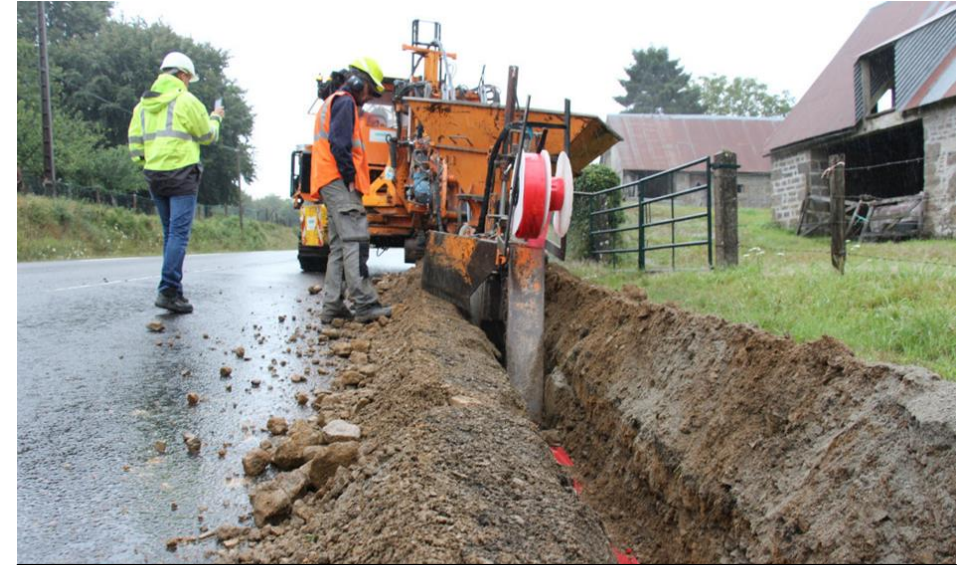
Chantier mobile d'enfouissement de ligne (source : https://actu.fr/normandie/flers_61169/entre-flers-et-tincherbay-cest-la-fin-dun-gros-chantier-denfouissement-de-lignes-electriques_1355402.html )
