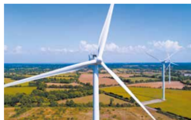
Plus les pales de l'éolienne sont longues, plus elle augmente sa capacité de production.
